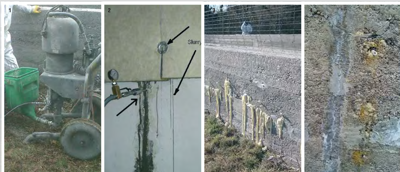
Foto 1) Miscelazione del Penetron Inject, bicomponente, in apposita pompa da boiacca cementizia fluida - Foto 2) Predisposizione dei packer da iniezione e iniezione della boiacca viscosa a pressione - Foto 3) Penetron Inject può essere utilizzato insieme a resine poliuretatiche idroespansive elastiche - Foto 4) Reazione cristallina sigillante in una fessurazione
