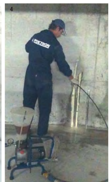
Foto 1) Lesione con fuoriuscita di acqua in spinta idraulica - Foto 2) Predisposizione dei fori per i packer di iniezione - Foto 3) Fissaggio dei packer a tenuta nei fori Foto 4) Iniezione con pompa elettrica della resina idroespansiva elastica.
