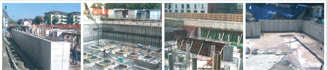
Foto 1) Strutture interrate doppio cassero a pannelloni tradizionale (Residenziale Cascina Casella, Cremona) - Foto 2) Strutture interrate contro pali (Residenziale Via Monte Ortigara, Torino) - Foto 3) Strutture interrate contro diaframmi (Residenziale Via Viganò, Milano) - Foto 4) Cassero a perdere doppia lastra BILBOTPROOF® (Residenziale Strada Valsalice, Torino)
