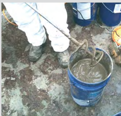
Miscelazione del Penetron Standard in “boiaccia” densa e mielosa
