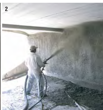
Foto 1) Spritz beton impermeabile di risanamento profilo ammalorato di galleria ferroviaria - Foto 2 - 3) Spritz beton impermeabile contro pali di parcheggio interrato Foto 4) Crescita cristallina nel tempo veicolo umidità nelle fessurazioni e porosità residue dello spritz beton
