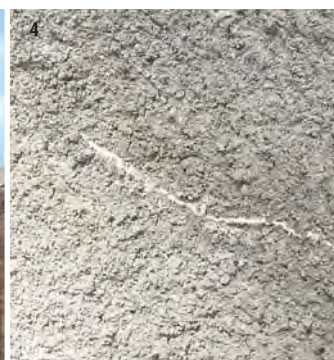
Foto 1) Spritz beton impermeabile di risanamento profilo ammalorato di galleria ferroviaria - Foto 2 - 3) Spritz beton impermeabile contro pali di parcheggio interrato Foto 4) Crescita cristallina nel tempo veicolo umidità nelle fessurazioni e porosità residue dello spritz beton
