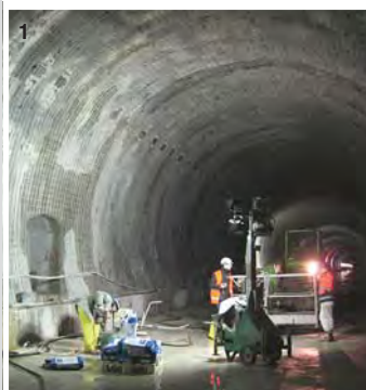
Foto 1) Spritz beton impermeabile di risanamento profilo ammalorato di galleria ferroviaria - Foto 2 - 3) Spritz beton impermeabile contro pali di parcheggio interrato Foto 4) Crescita cristallina nel tempo veicolo umidità nelle fessurazioni e porosità residue dello spritz beton
