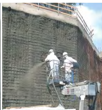
Foto 1) Spritz beton impermeabile di risanamento profilo ammalorato di galleria ferroviaria - Foto 2 - 3) Spritz beton impermeabile contro pali di parcheggio interrato Foto 4) Crescita cristallina nel tempo veicolo umidità nelle fessurazioni e porosità residue dello spritz beton
