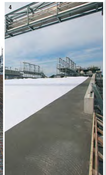
Foto 1) Spolvero su superfici orizzontali fresche di getto - Foto 2) Finitura con elicottero - Foto 3) Fasi esecutive - Foto 4) Maturazione umida delle superfici
