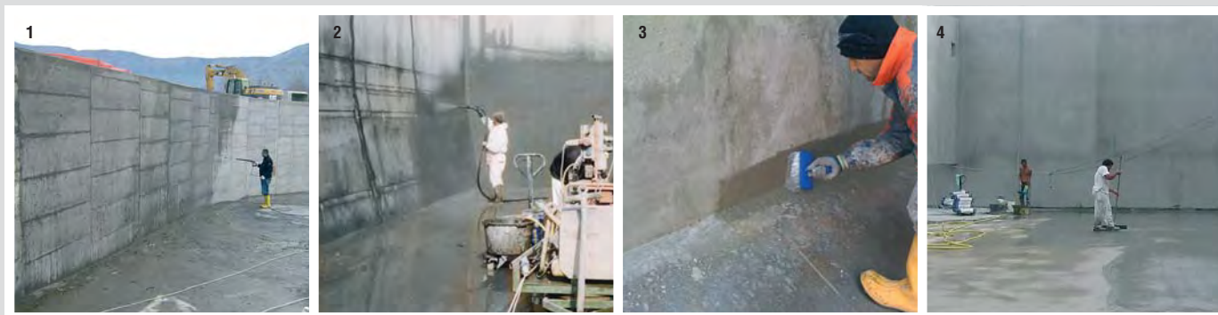
Foto 1) Pulizia e lavaggio del supporto - Foto 2) Applicazione a spruzzo - Foto 3) Applicazione a pennello - Foto 4) Applicazione a spazzolone
